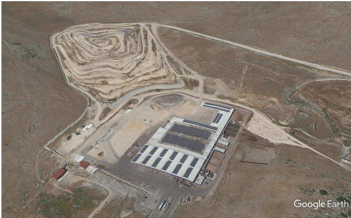
Foto 2.3.6 Impianto TMB e Discarica Bellolampo Palermo: IMMAGINE GOOGLE 20.05.2020
